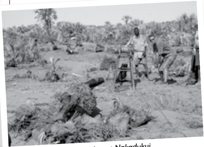
Clearing stumps Nakadukui.
